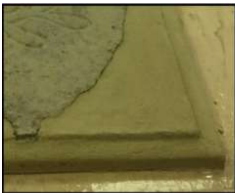
Рисунок 20. Восполненный фрагмент, покрытый ретушью
