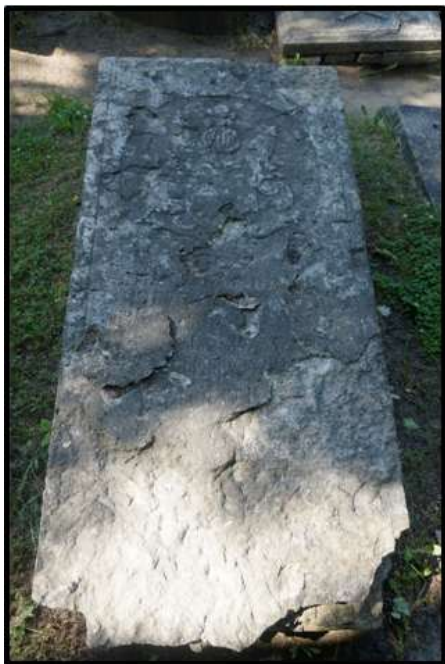
Рисунок 5. Следы выветривания на надгробной плите из известняка. Санкт-Петербург, Некрополь XVIII века
