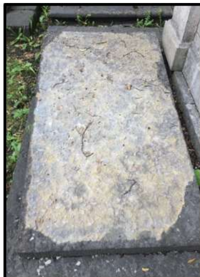
Рисунок 10. Нижняя часть расслоившейся надгробной плиты М.П. Нефедовой
