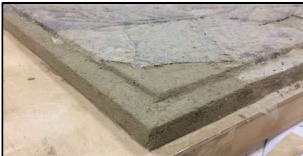
Рисунок 19. Восполнение утрат плиты при помощи камнезаменителя
