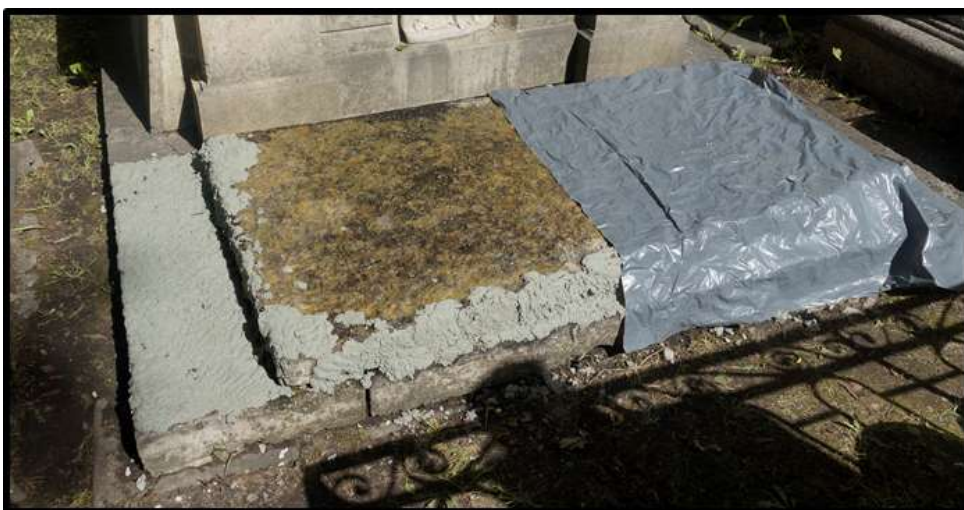
Рисунок 22. Удаление загрязнений при помощи компресса
