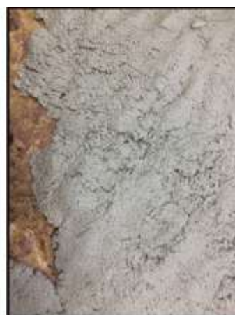
Рисунок 16. Удаление стойких поверхностных загрязнений с фрагментов плиты при помощи компресса
